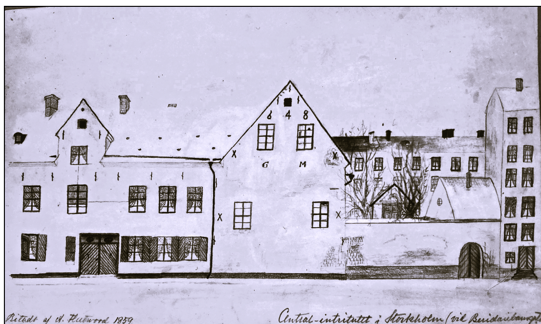
Anna Fleetwoods teckning av fasaden mot Beridarebangatan. Gerdt Meijers initialer på gaveln till kanongjuteriets gjuthus med byggnadsår 1648, t.v. bostaden på andra våningen; Stockholm, Norrmalm, Nordiska Museets arkiv.
